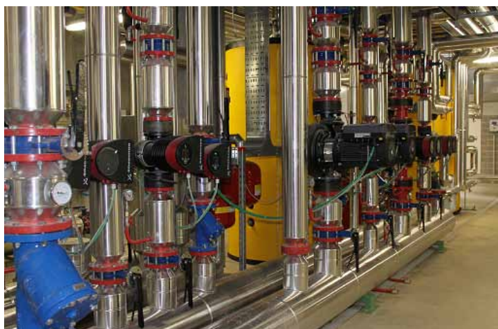
Foto: Installazione Pompe MAGNA3 e TPE Grundfos
