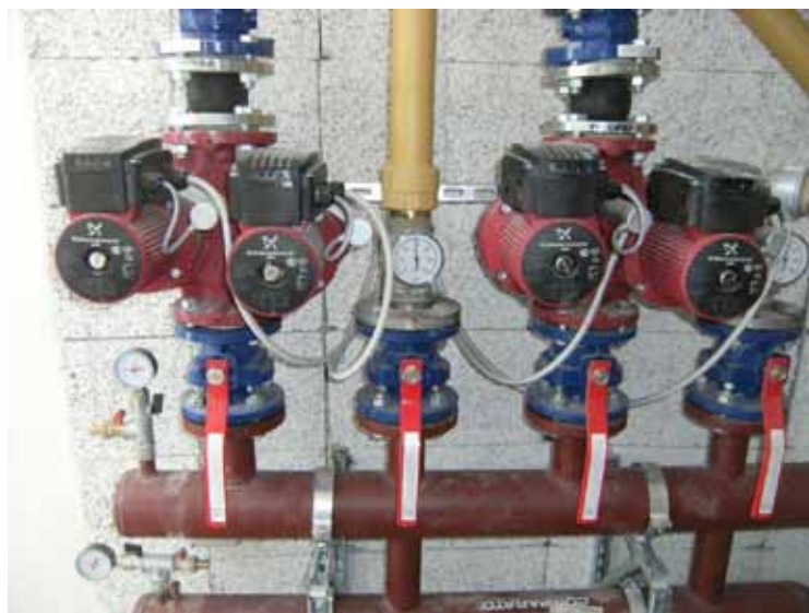
Foto: Installazione Pompe Grundfos
