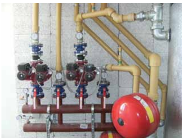
Foto: Installazione Pompe Grundfos
