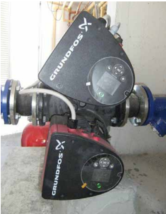
Foto: Installazione Pompe Grundfos
